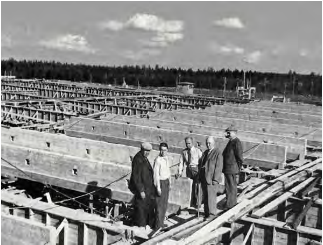
Veturikorjauspajan kattopalkkeja tarkastamassa. Toinen vasemmalta isäni, toinen oikealta AK. Ei ole tuon ajan työturvallisuus ihan tätä päivää. Kuva AK:n perhealbumi
