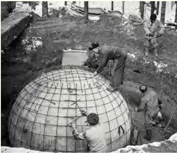
Imubetonipallokorsujen valua. Sisäpuolisena muottina toimi kumipallo. Kuva SA-kuva
