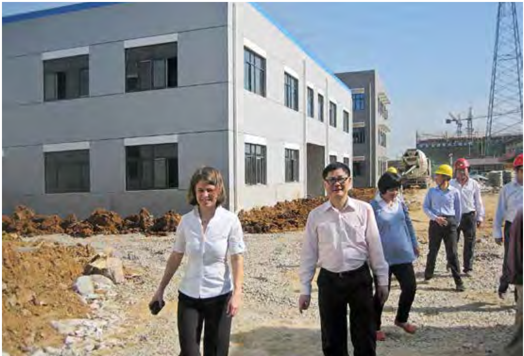
Hanna ja uskottu miehemme Georg Lai eli Ykä tarkastuskäynnillä NJOP:n uuden tehtaan työmaalla
